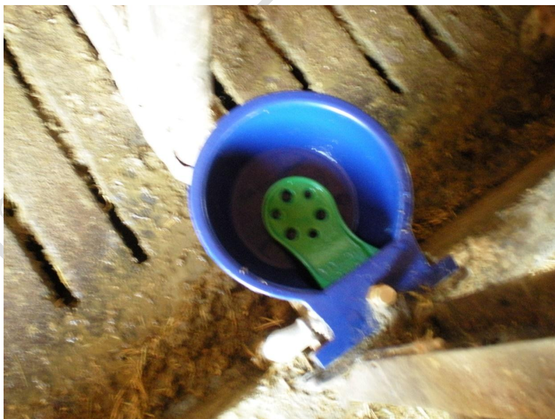
Figura 4 - Esempio di abbeveratoio a spinta pulito.
