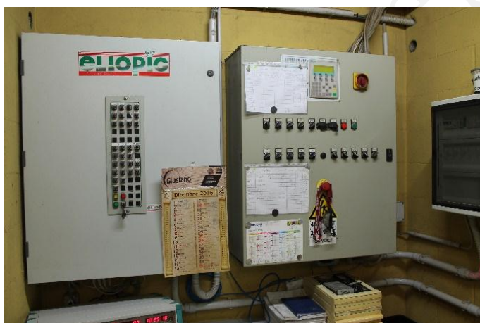
Figura 13. Impiego di sistemi computerizzati di miscelazione
