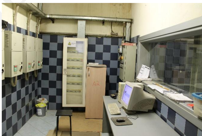
Figura 14. Impiego di sistemi computerizzati di miscelazione
