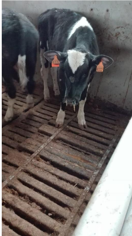
Figura 47. Fessurato in legno non idoneo
